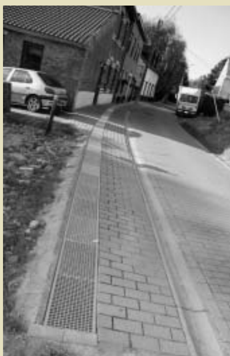
Zwartenbroek aanleg afwatering tegen overstromingsgevaar
