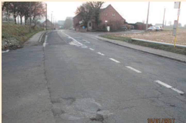
▲ Grondige renovatie Schapenstraat al jaren nodig
