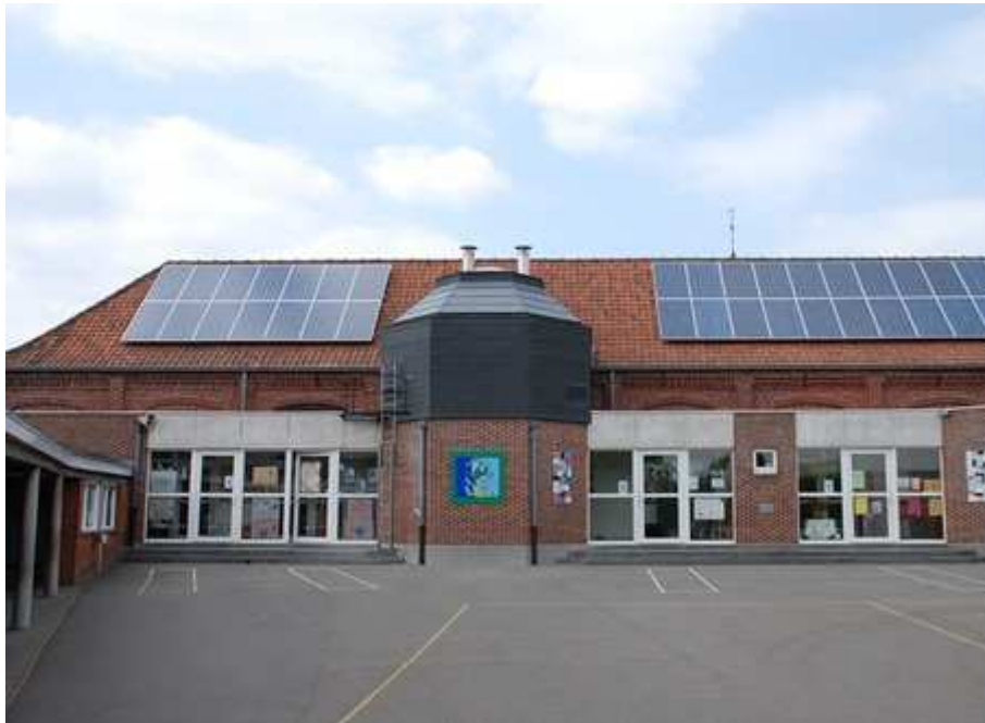
PV op scholen, voorbeeld Zonnewindt
